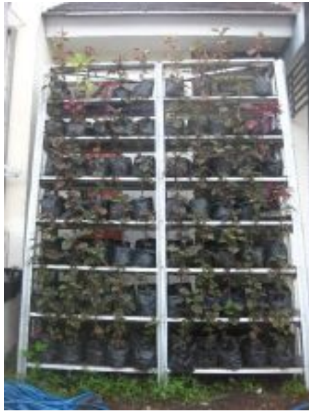
Gambar 6. Penataan taman pada rangka besi
