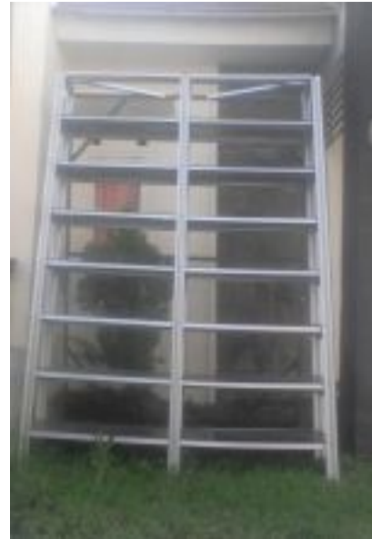
Gambar 5. Rangka besi yang telah terpasang
