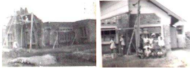
Gambar 5. Foto proses pembangunan rumah
