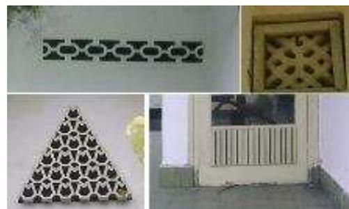
Gambar 5 Tipologi Lubang Angin
