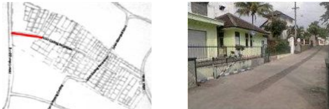
Gambar 9. Kondisi jalan yang mengikuti arah kontur
